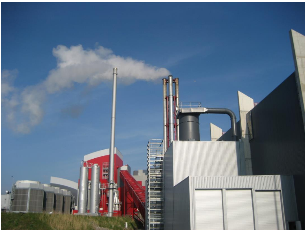
Biomasseheizkraftwerk (Alkmaar, Niederlande)
